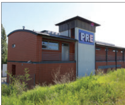
Rozvodna PREDistribuce (Praha-Pankrác) - ilustrační foto
