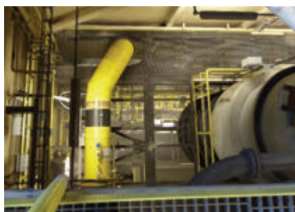
Potrubié vysokopecného plynu
