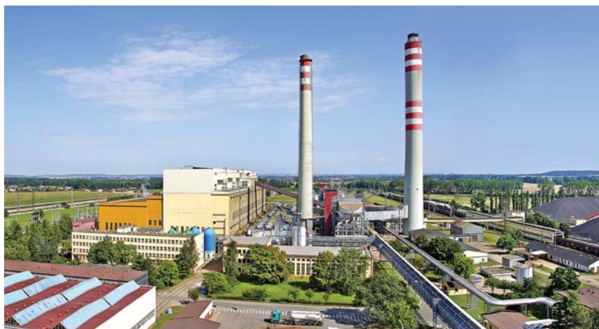
Celkový pohled na teplárnu Opatovice – ilustrační foto
