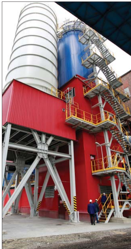
Objekt odsíření v Teplárně Karviná
