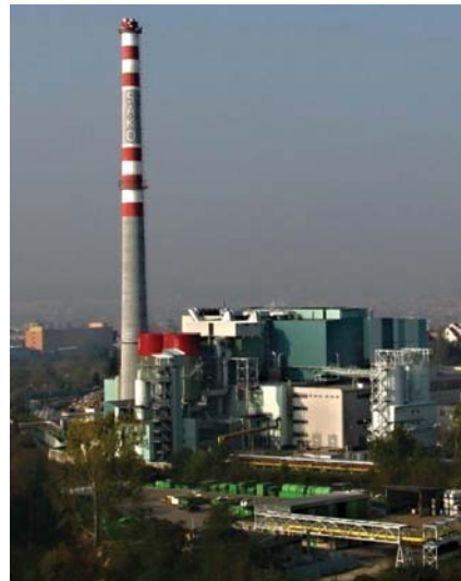
Obr. 1 – Brněnská spalovna komunálních odpadů (SAKO Brno a.s.)
