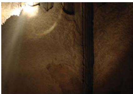
Obr. 3 – Ukázka silného zanesení spalinového kanálu z konce února 2014, kdy kotel K2 musel být kvůli zanesení odstaven
