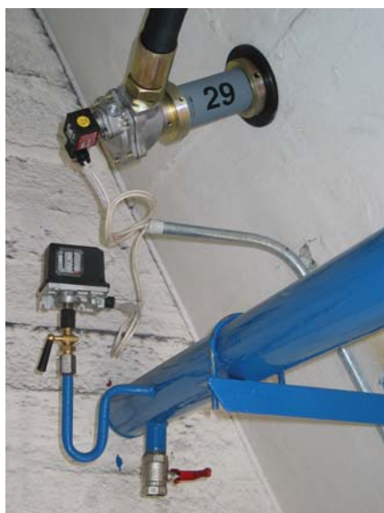
Řešení toku paliva v betonových zásobnících (HEXION, a.s.)
