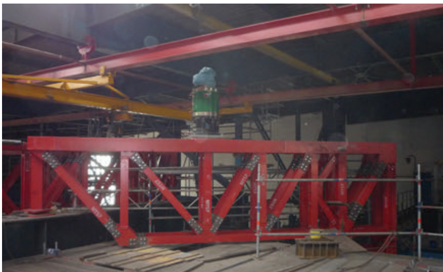
Provizorní příhradová konstrukce a lis
