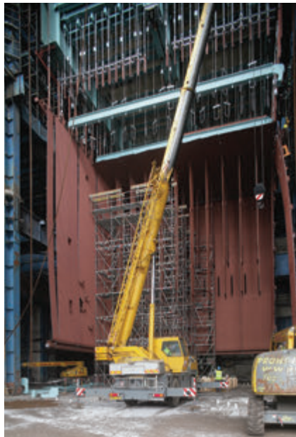
Montáž membránových stěn
