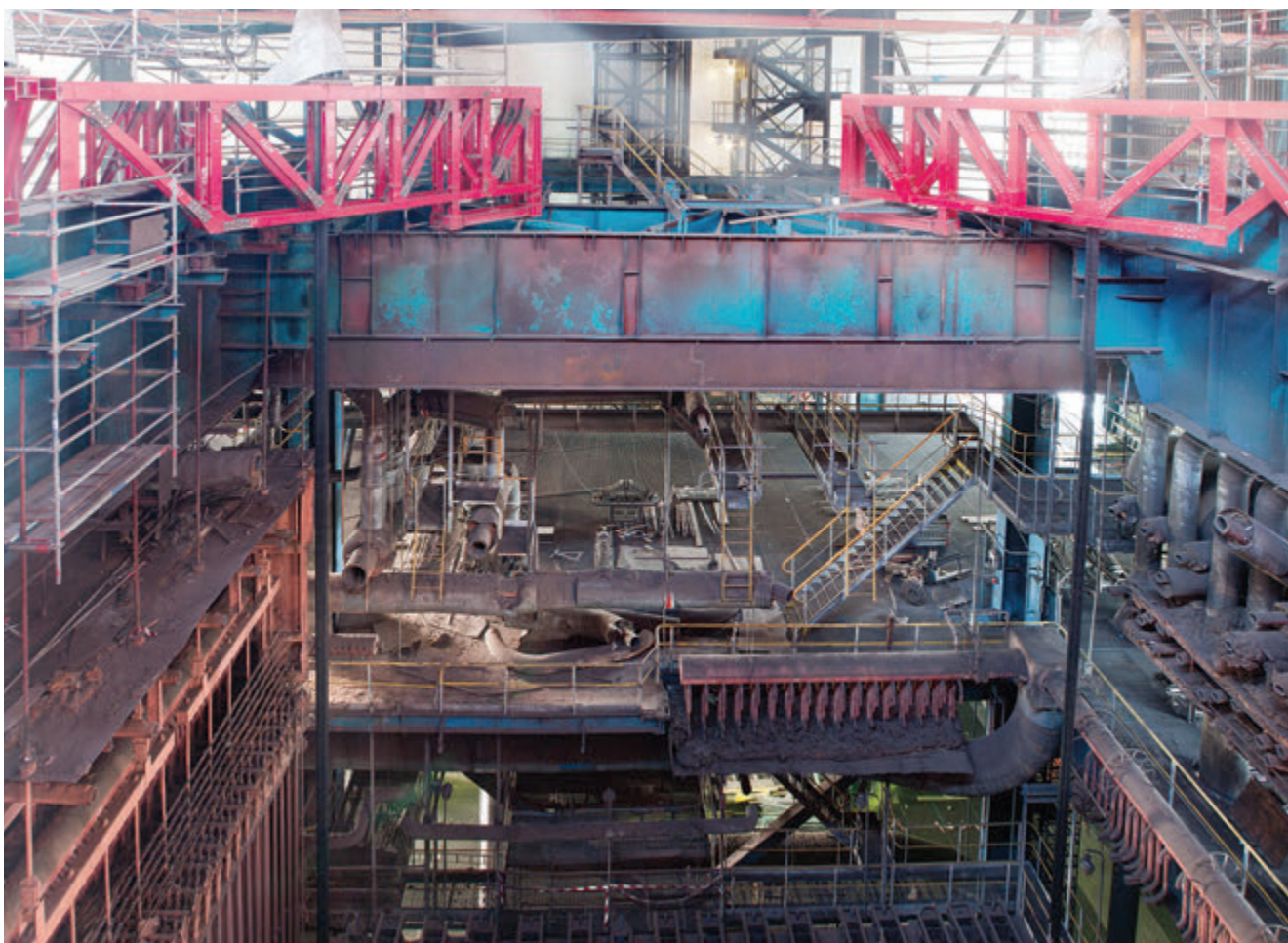
Provizorní příhradová konstrukce s osazenými lisy a lany
