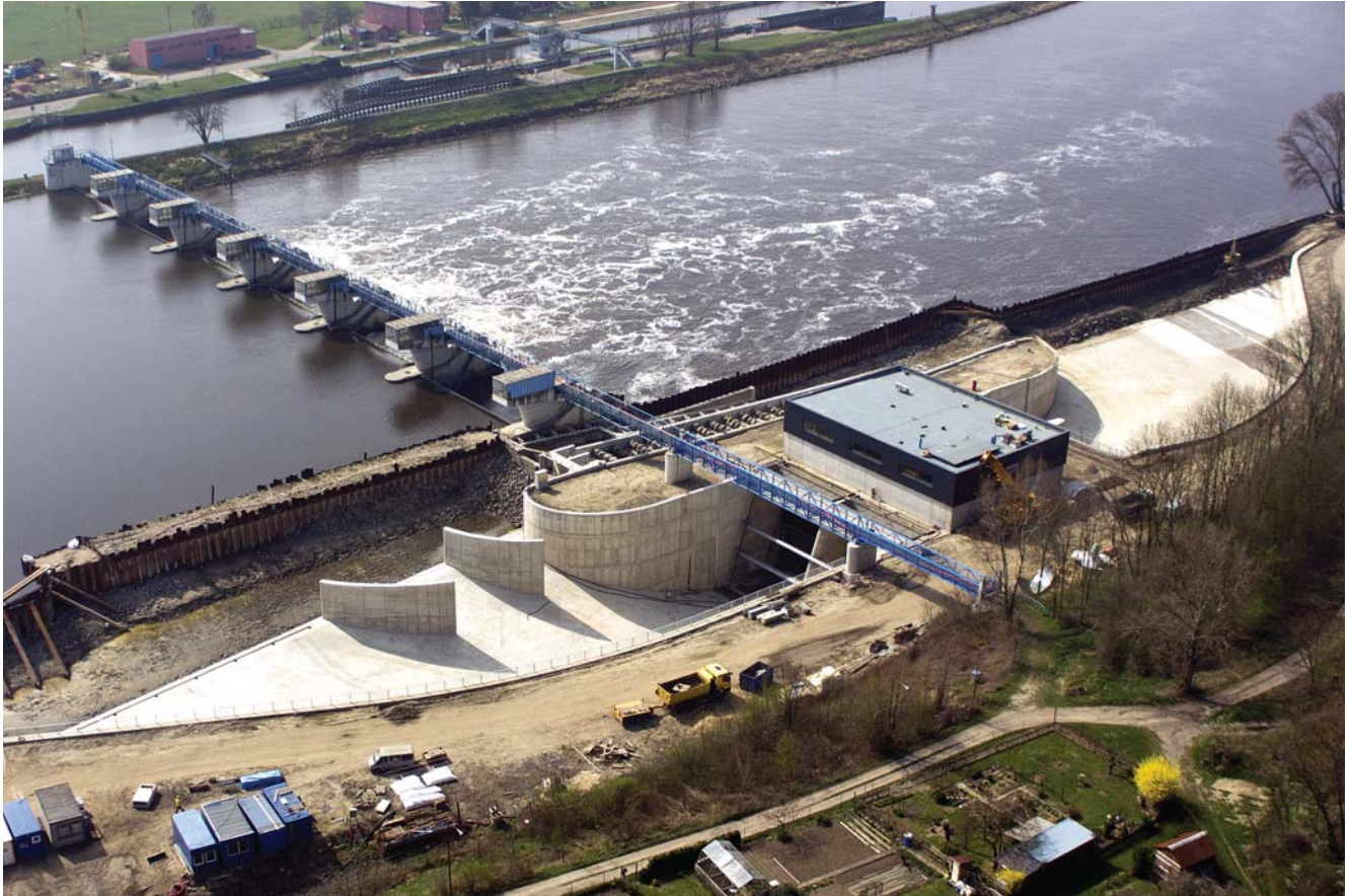
Letecký pohled na výstavbu elektrárny Štětí na Labi
