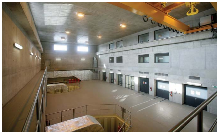
Hlavní budova MVE Štětí
