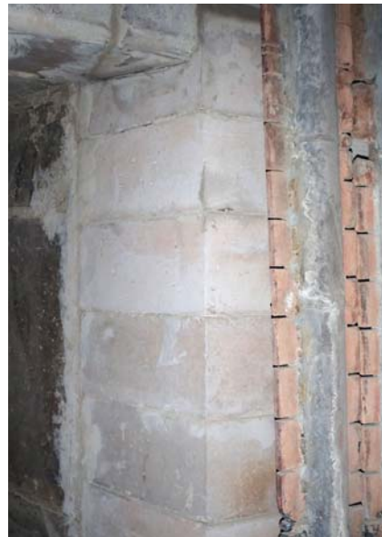
Boční pohled na přechod vyzdívek a membránové stěny
