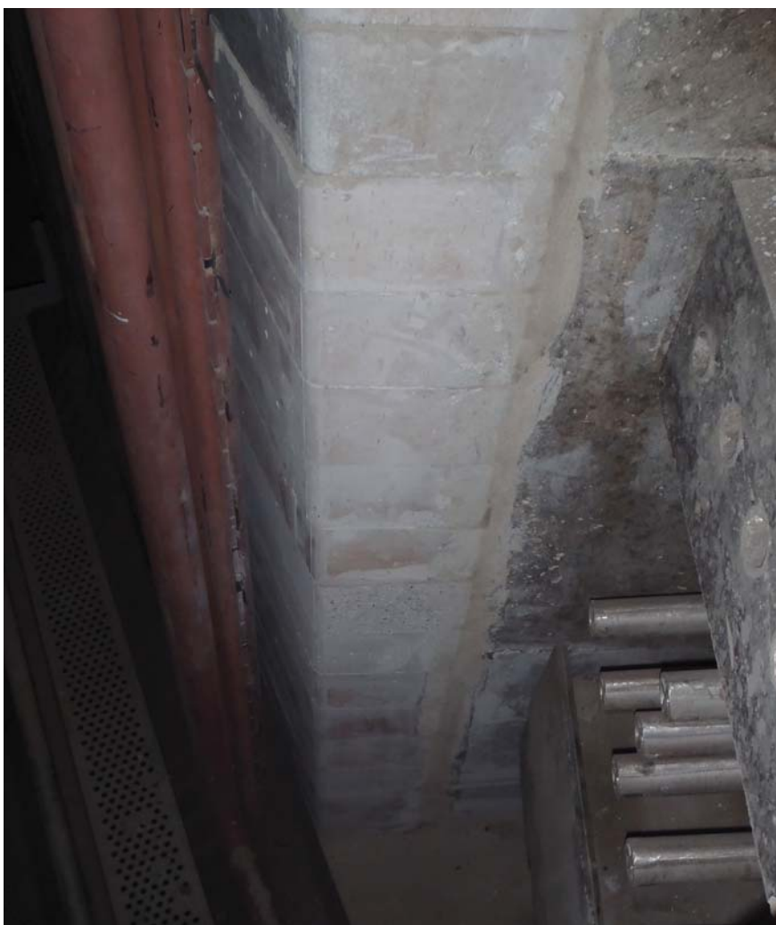
Pohled na žárobetonové tvarovky hořáku
