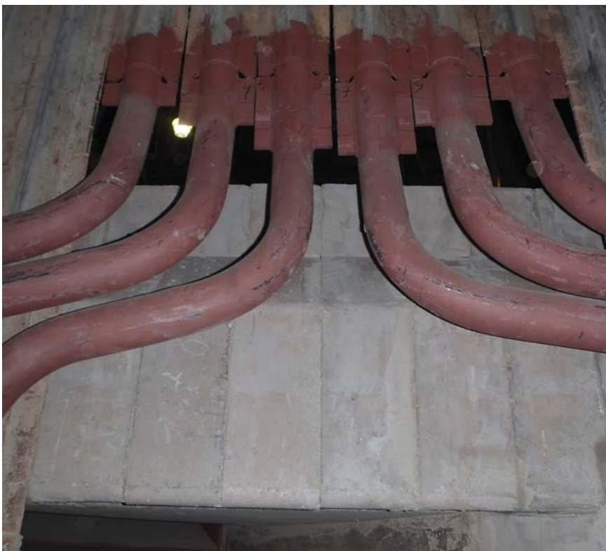
Osazení horních tvarovek hořáku
