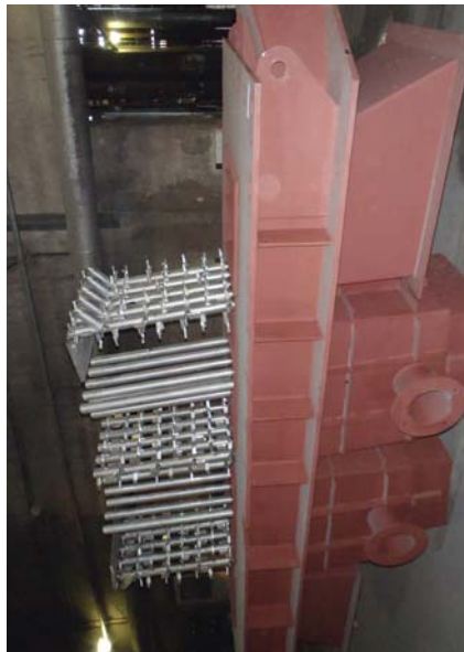
Pohled na stěny chlazení po a před zabudováním
