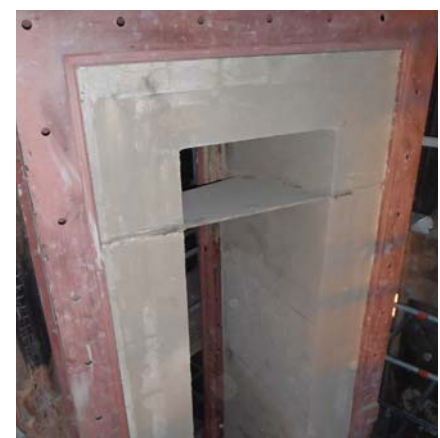
Vybetonovaný ocelový rám hořáku
