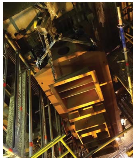
Obr. 5 - Instalace hořáku (kotel K4)
