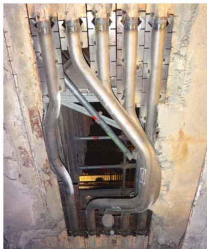
Obr. 6 - Výhyby pro dýzy dohořivacích vzduchů
