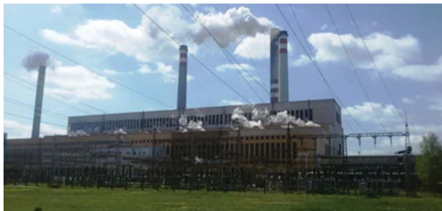
Obr. 1 – Pohled na elektrárnu Mělník I
