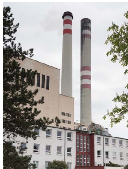
Pohled na správní budovu Energotrans, a.s. V pozadí budova výrobního bloku.
