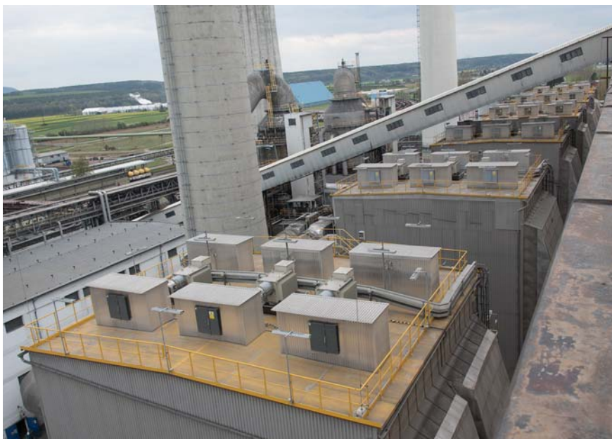
Pohled (ze směru kotle K6) na střechy s elektroodlučovači. Ve střední části je vidět zauhlovací most
