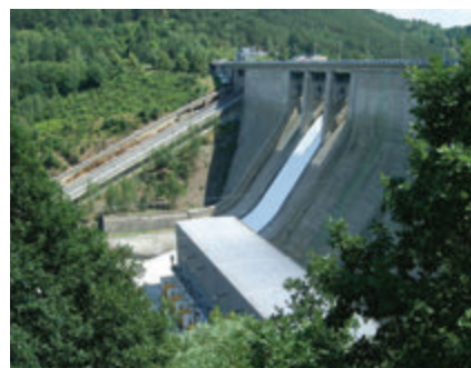
Pohled na hráz vodní elektrárny Orlík
