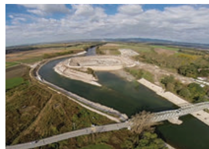
Výstavba nové vodní elektrárny Břežice na řece Sáve ve Slovinsku
