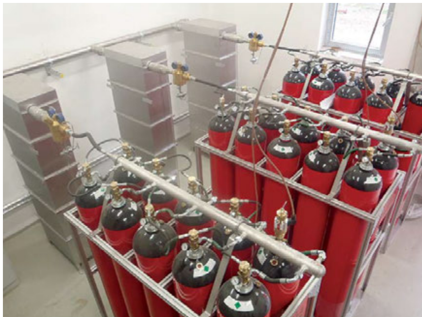
Obr. 2 – Rozvodna SHZ
