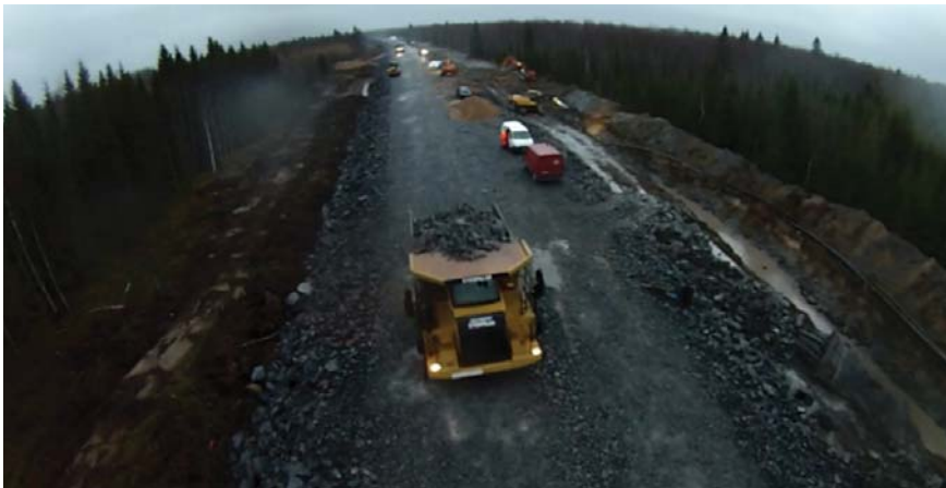
Aktuálně jsou v plném běhu práce na zajištění potřebné infrastruktury
