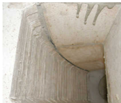
Detail provedení vnitřku čtvercového oblouku. Ve spodní části je vidět přechodový díl čtverec/kruh
