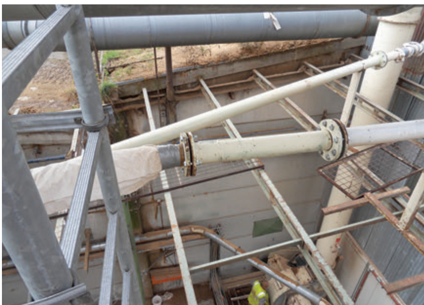
Optimalizace investic. V původním návrhu zastřešeno, v rámci realizace odstraněno pro nadbytečnost
