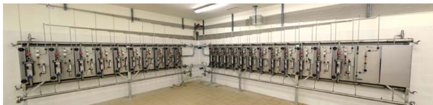
Instalace měření ropných látek na ukliďňovací nádrži elektrárny Pruněřov II
