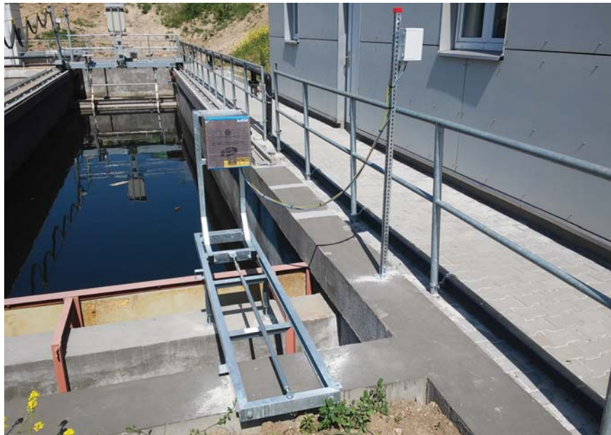
Instalace měření ropných látek na ukliďňovací nádrži elektrárny Pruněřov II
