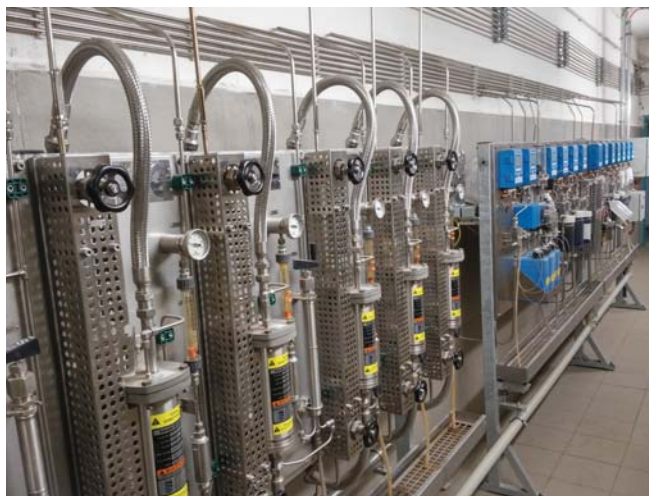
Dodávky pro KO elektrárny Prunéřov II (vzorkovna a úprava vzorku na BUK)
