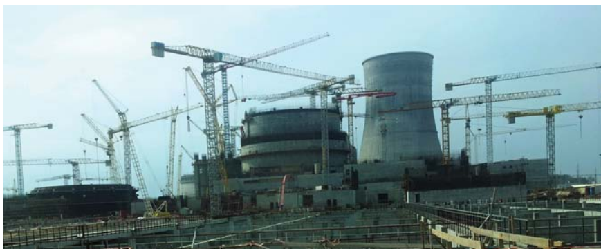
Rozestavěné dva bloky jaderné elektrárny Ostrovec
