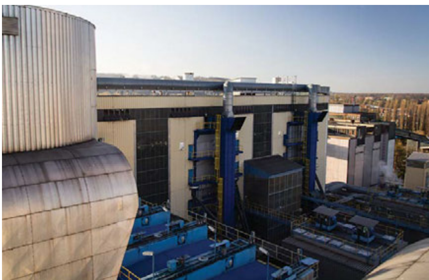
Pohled na kotelnu teplárny
