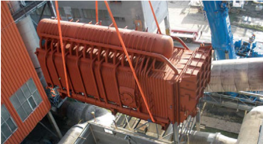
Snímek z montáže kotle K4
