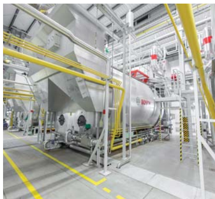
Vybrané spalovací zařízení dokáže spolehlivě a trvale ve všech provozních stavech plnit přísné limity NO x a CO
