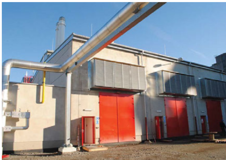
Dokončený objekt výrobního bloku s plynovými motory
