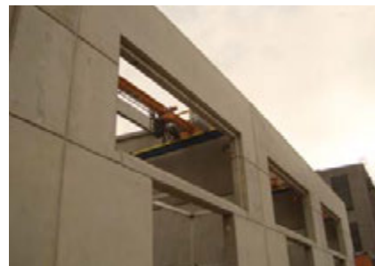
Betonová konstrukce výrobního bloku
