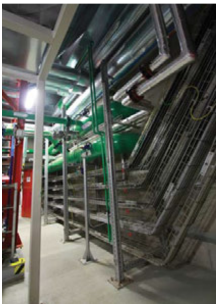
Celkový pohled na sdržený závěs ze systému MI, MQ
