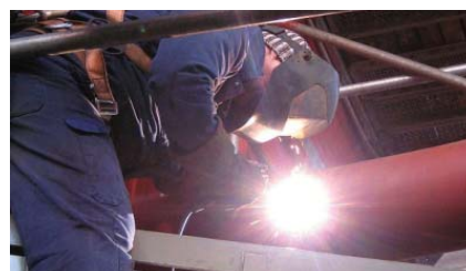
Snímek z montáže potrubních systémů
