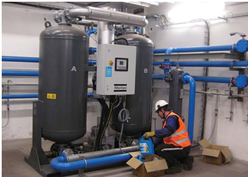
Momentka z instalace jedné z technologií
