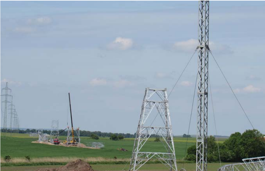
Pohled na staveniště
