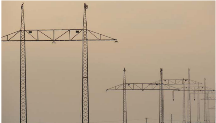
Stožáry připravené na instalaci vodičů a příslušenství
