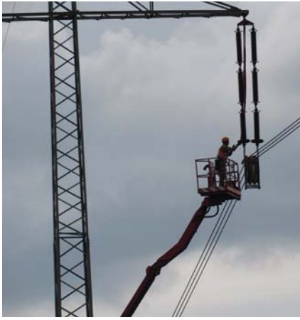
Montáž izolátorů
