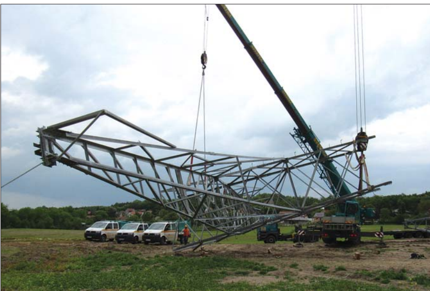
Manipulace s ocelovými konstrukcemi
