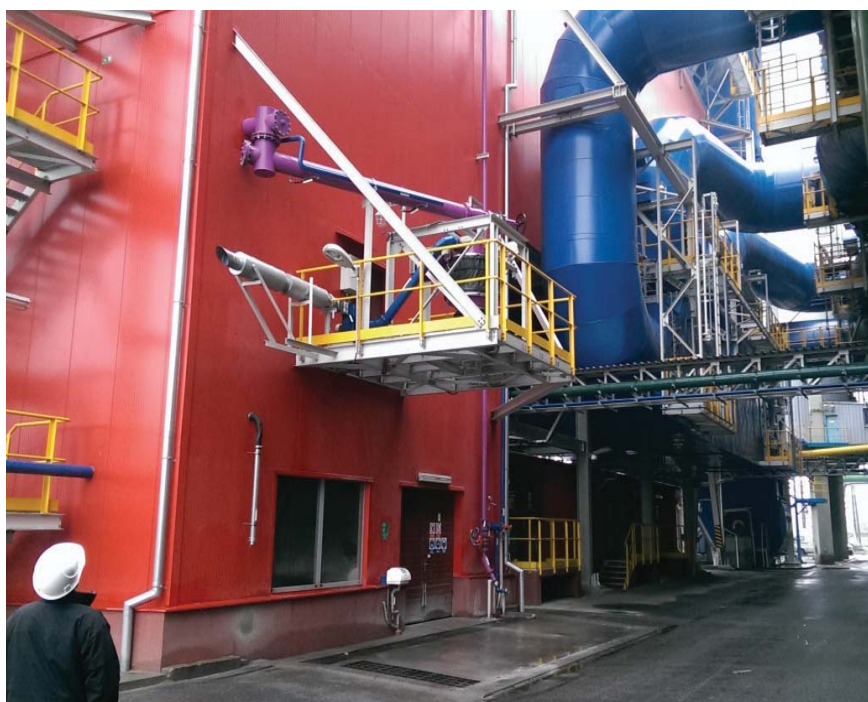
Pohled na ocelové konstrukce (úroveň 3) pod absorber a filtr
