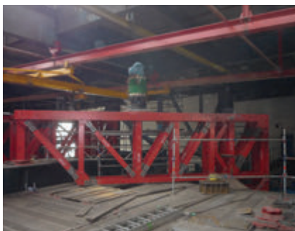
Obr. 2 – Diagonální nosník PPK s liselem
