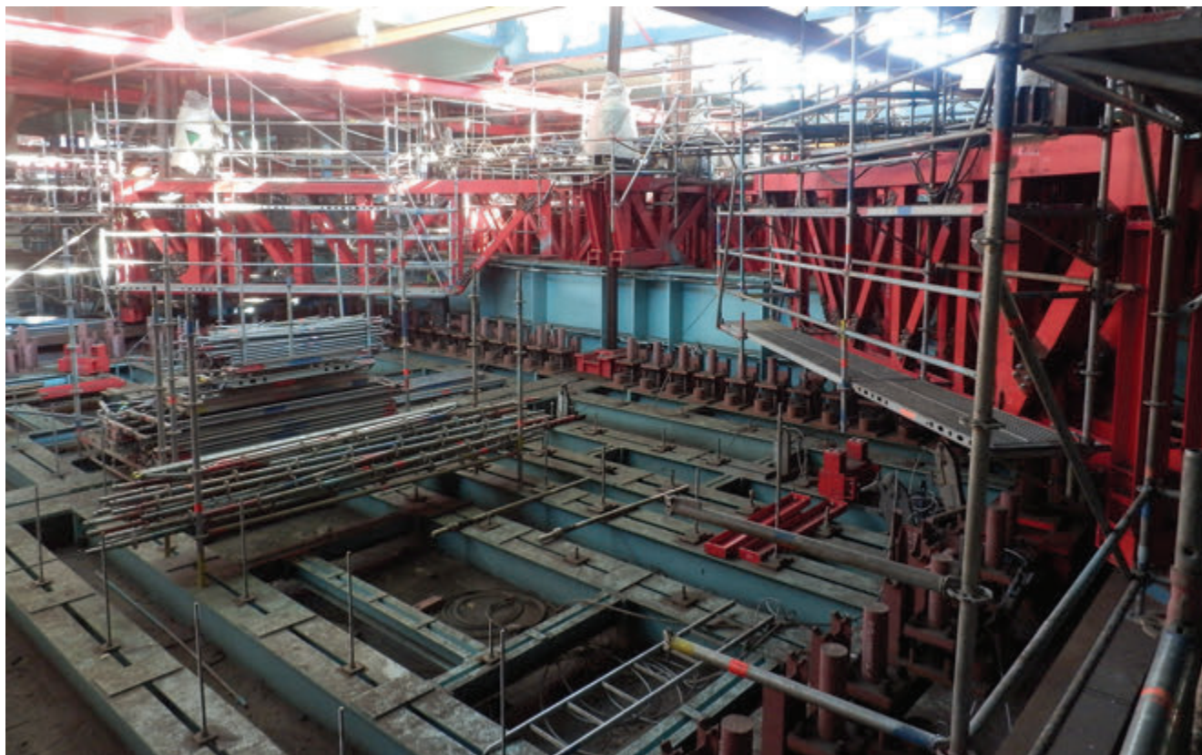
Obr. 20 – Nosný rošt prvního tahu po zdvižení do finální pozice
