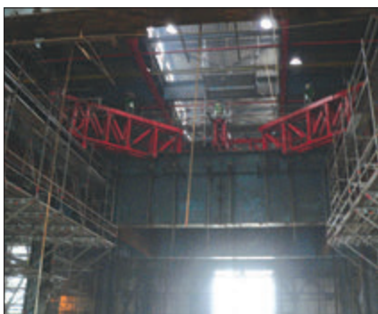
Obr. 17 – Nosníky 1. tahu směrem k mezitahu
