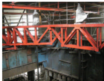
Obr. 3 – PPK po spuštění roštu s kotlem
