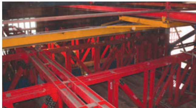
Obr. 13 – Nosníky kolmé na osu kotle
