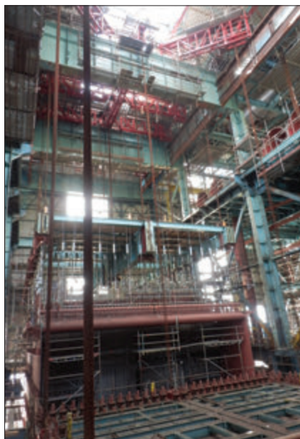
Obr. 18 – PPK a zavěšené části nového kotle v průběhu zdvihu
