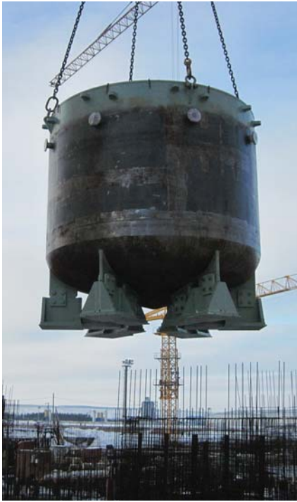
Lapač taveniny na staveništi Novovoronežské JE II
