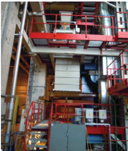
Celkový pohled na dodanou technologii
