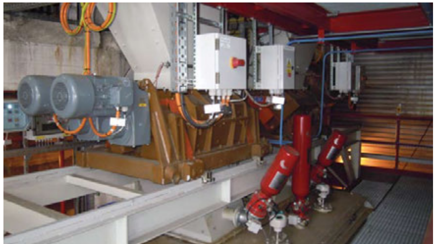
Pohled na drtiče a na zabezpečení proti výbuchu
