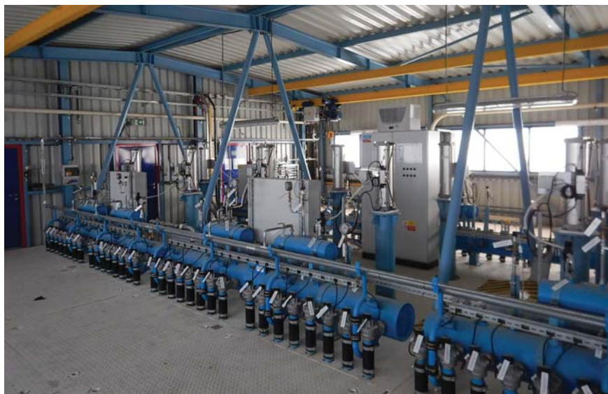
Prostor tzv. Penthausu (vzdušníky pro oklepy rukávců filtru)
