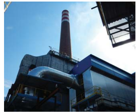
Napojení na elektroodlučovač
