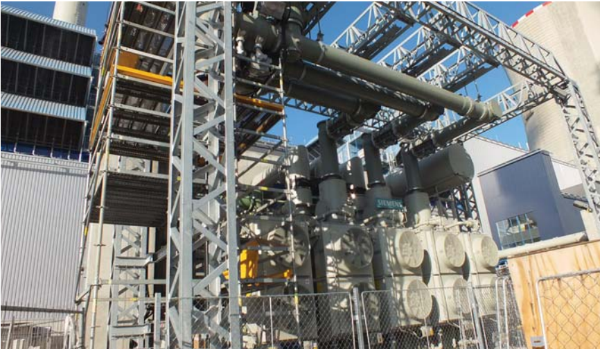
Venkovní část GIS a blokový transformátor
