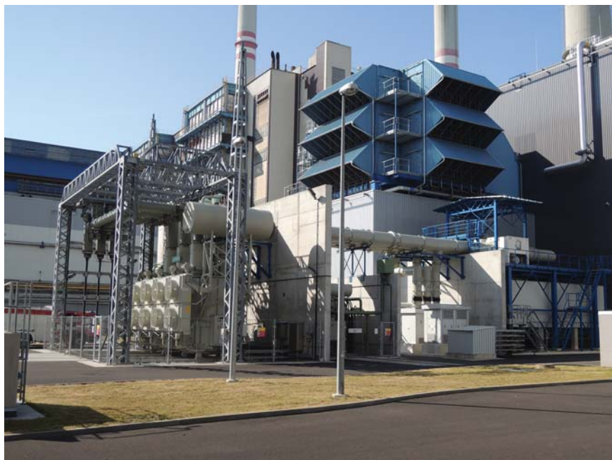
Vyvedení výkonu bloku č. 1 – celkový pohled
