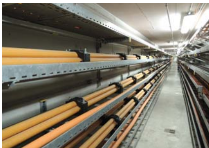
Kabelový propoj odbočkových transformátorů do rozvodny 6kV
