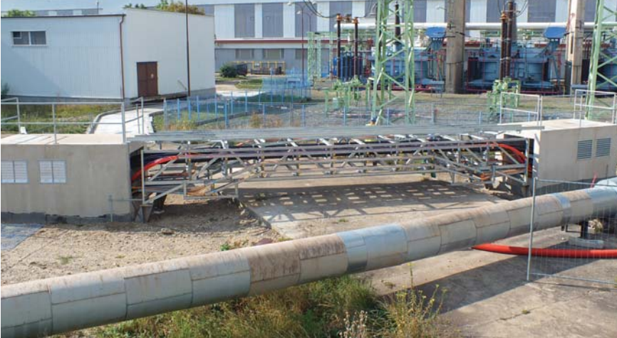
Nadzemní přechod vratného kanálu
