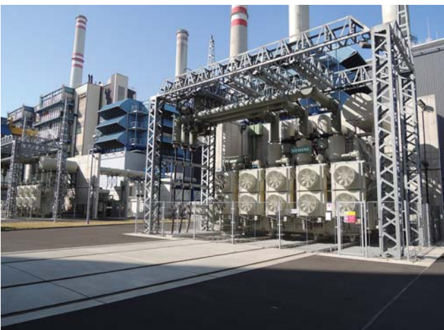
Připojení kabelů 400kV na stanovišti blokového transformátoru
