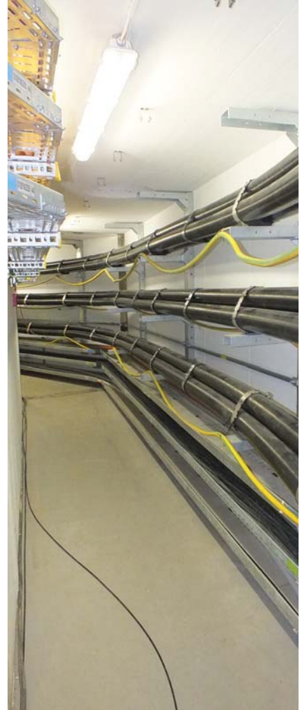
Konečné provedení uložení kabelů 400kV
