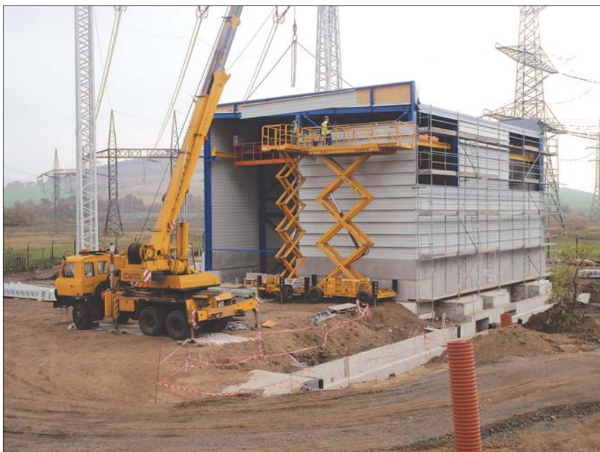
Zaústění kabelů 400kV do budovy rozvodny SO500
