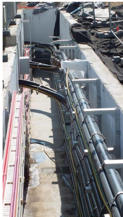
Zaústění kabelů 400kV do budovy SO500
