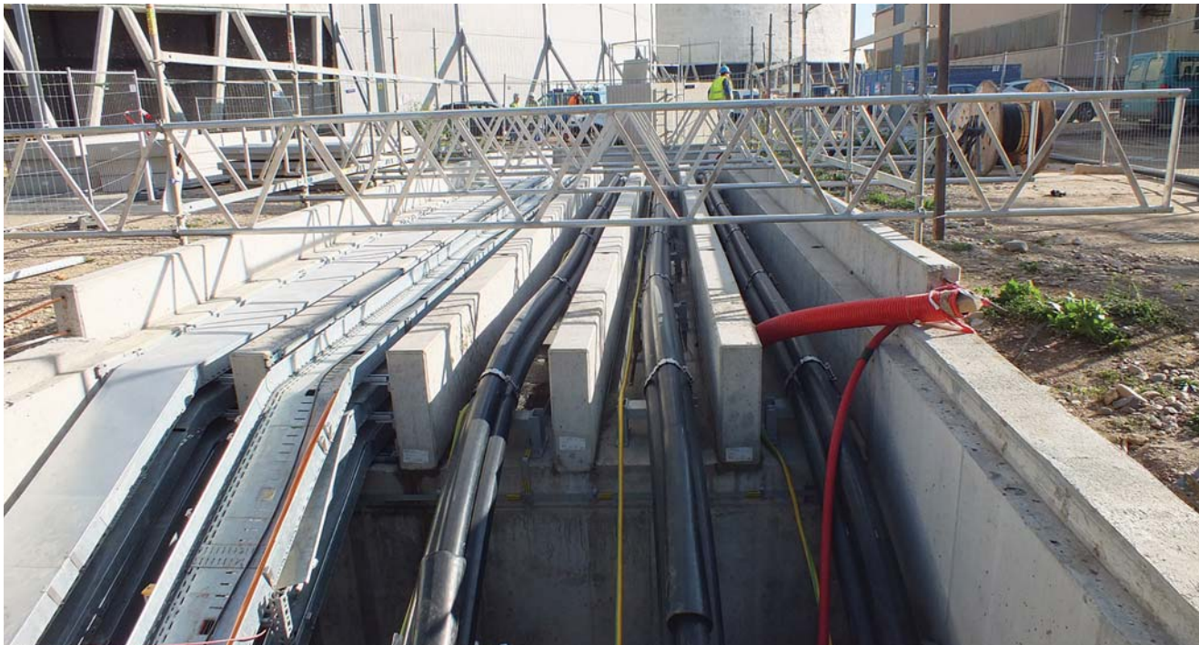
Uložení kabelů 400kV pod budoucí vozovkou v místě přechodu přes podzemní vedení chladicí vody
