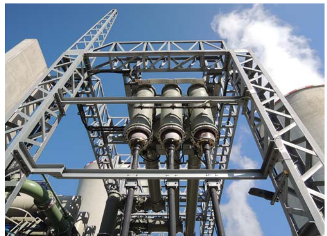
Připojení kabelů 400kV na stanovišti blokového transformátoru
