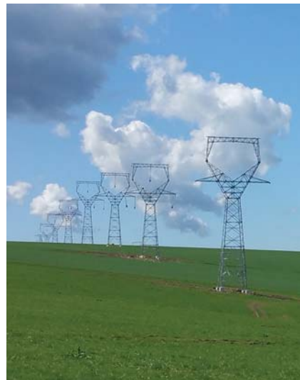
Stožáry na trase V458 připravené k instalaci příslušenství a natažení vodičů
