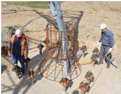
Příprava na betonáž základů
