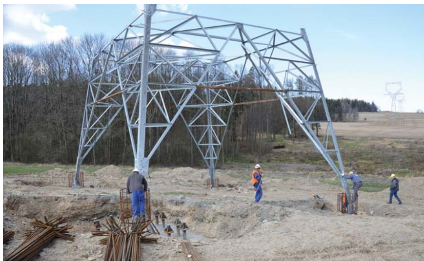
Výstavba V458 s sebou nese potřebu desítek tisíc m 3 betonu
