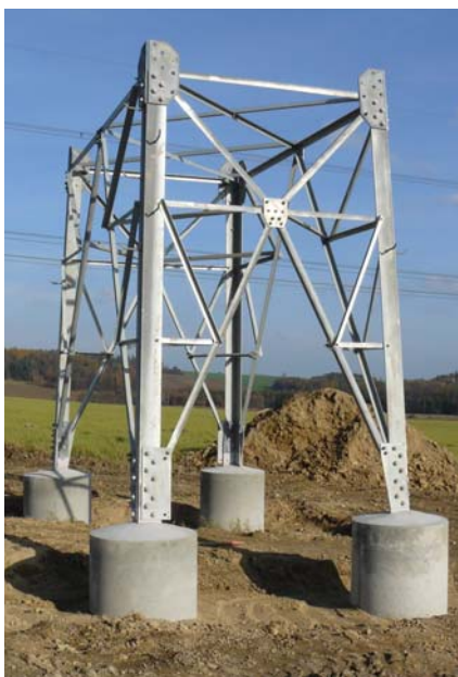
Část stožáru na betonovém základu
