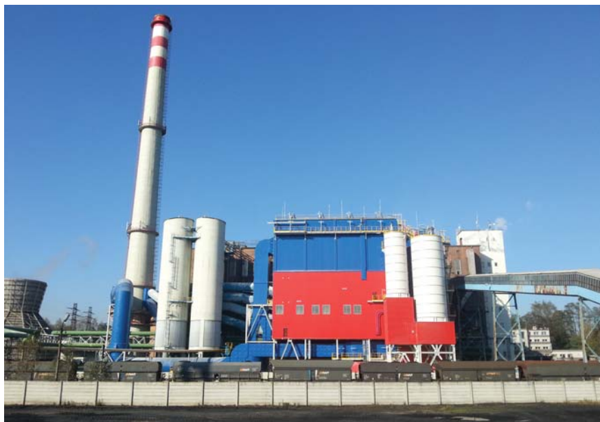
Teplárna Karviná po dostavbě technologie odsíření
