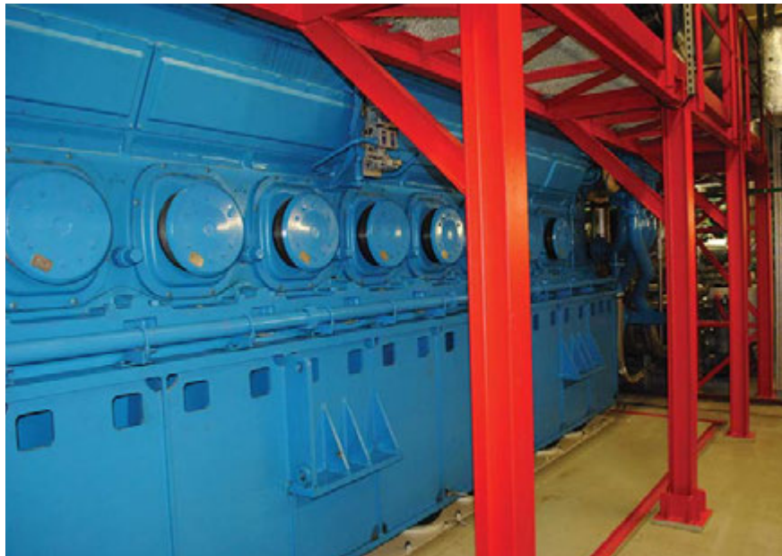
Pohled na nový kogenerační zdroj - plynový motor
