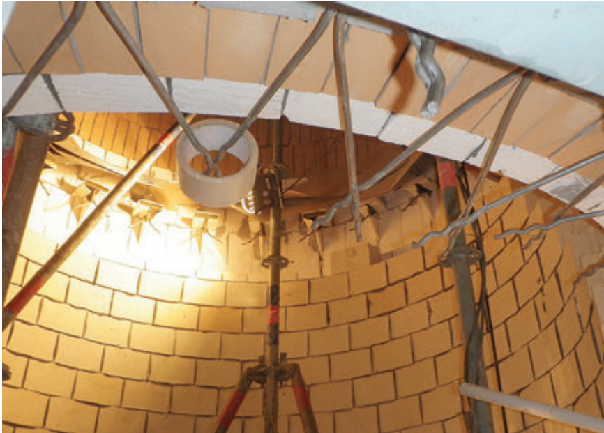
Vyzdívka sušící šachty s konzolí
