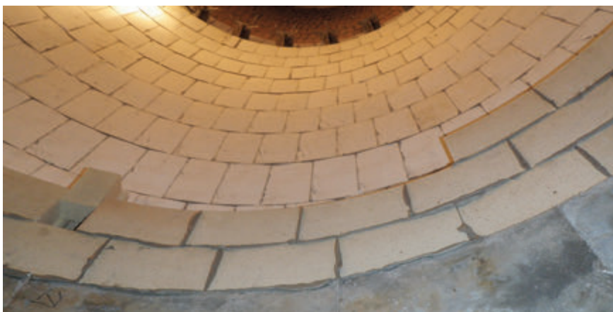
Vyzdívání sušící šachty
