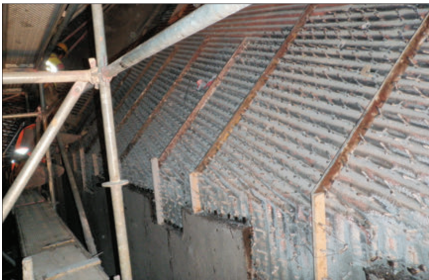
Příprava na shotcrete výsypky spalovací komory
