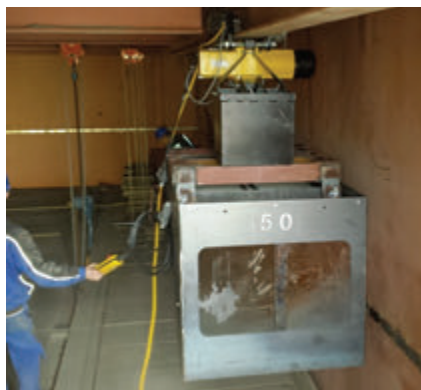
Obr. 6 – Montáž katalytických modulů
