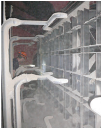
Obr. 5 – Vstřikovací mříž amoniaku
