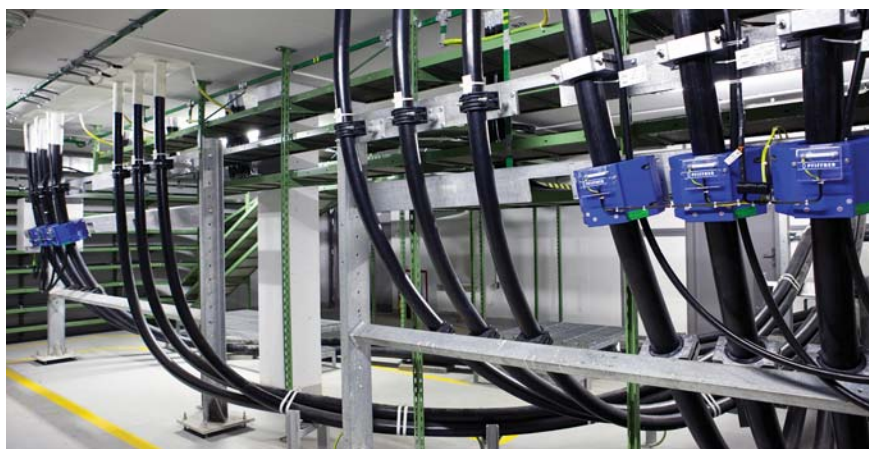
Transformovna Pankrác 110/22kV (Praha) - Výstavba nové zapouzdrěné, plynem izolované rozvodny 110kV s použitím dvou systémů přípojnic, osazením dvou transformátorů a čtyř vývodových polí 110kV
