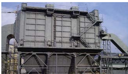
Elektrárna Pruněv II – Realizace zákotlí, elektročást pro elektroodlučovače
