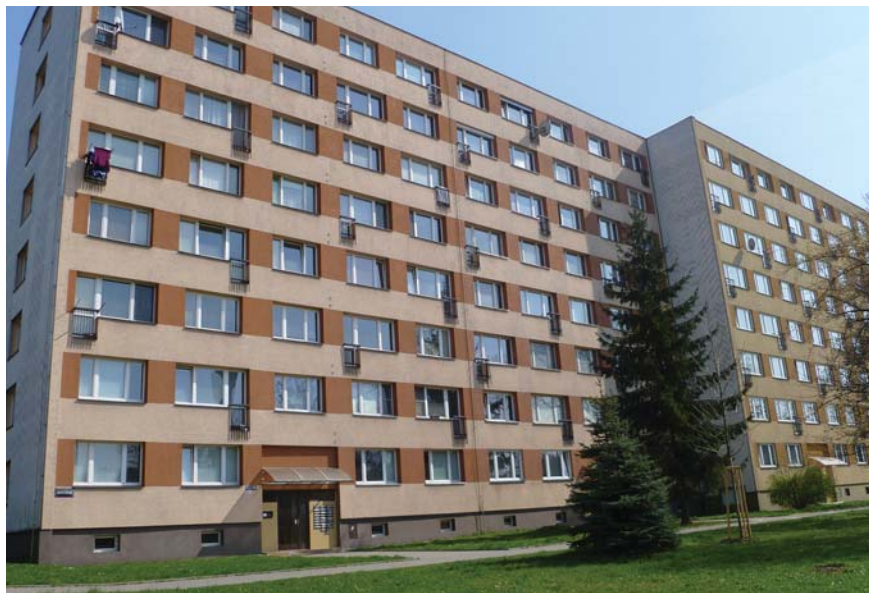
Zateplený bytový dům
