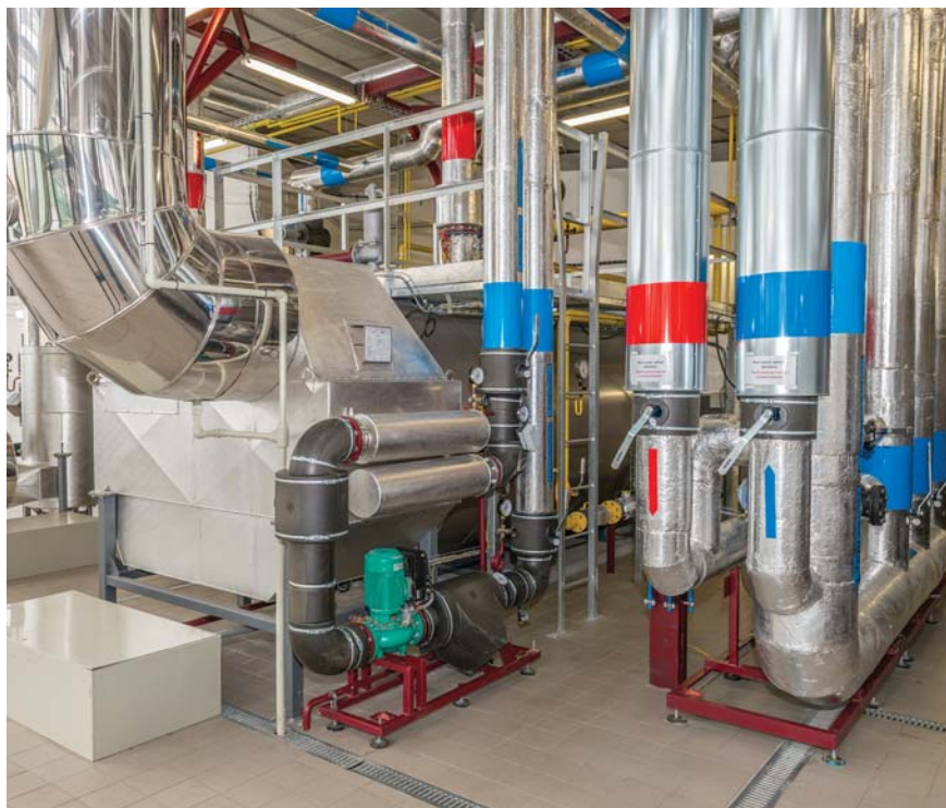
Pohled do kotelny
