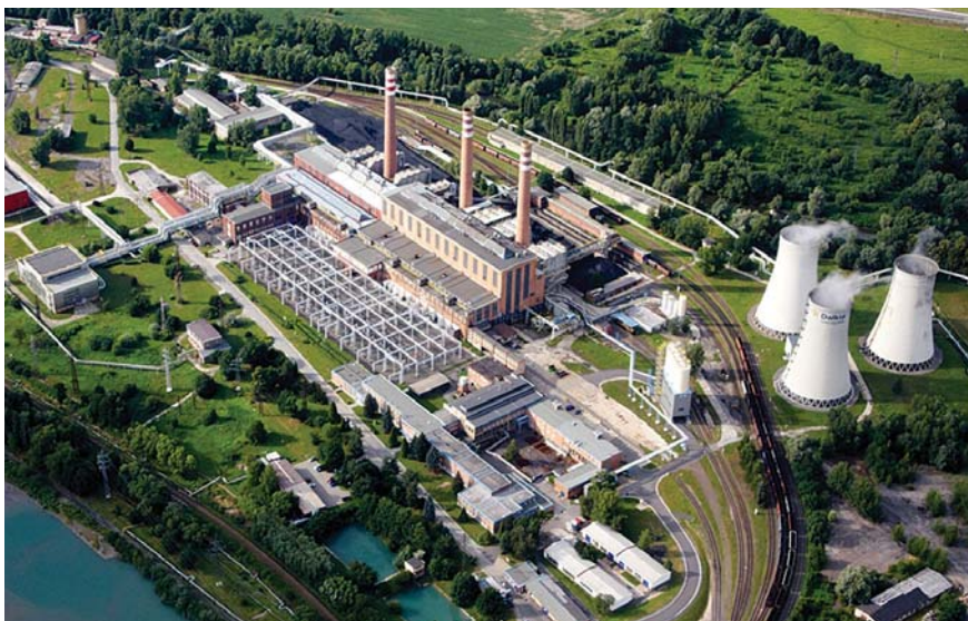
Letecký pohled na zdroj dálkového vytápění
