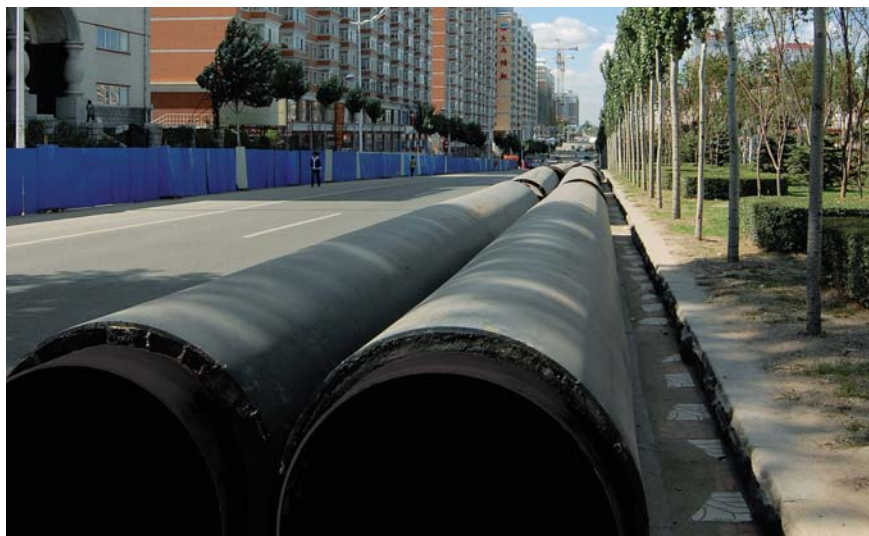
Potrubí pro dálkové vytápění
