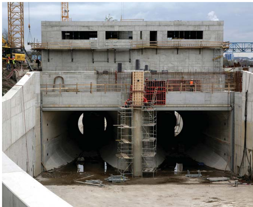
Snímek z výstavby Malé vodní elektrárny Štětí
