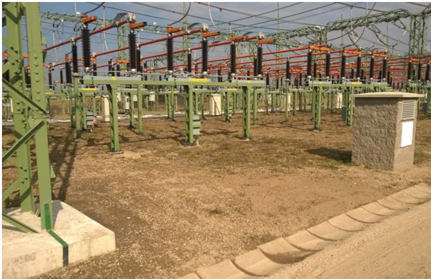
Modul po rekonstrukci
