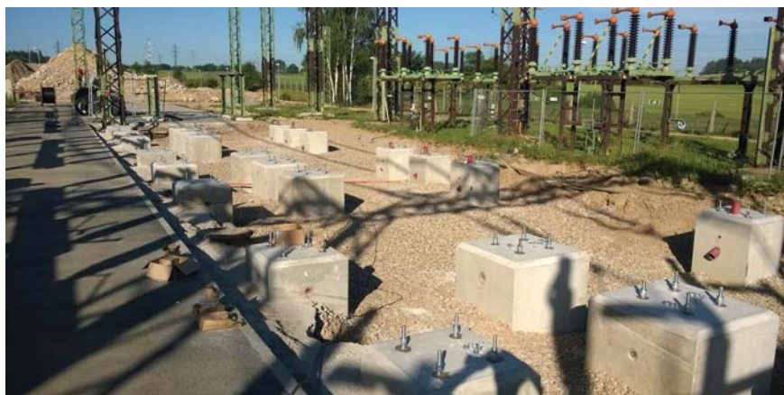
Vybetonované patky pro příhradové stožáry
