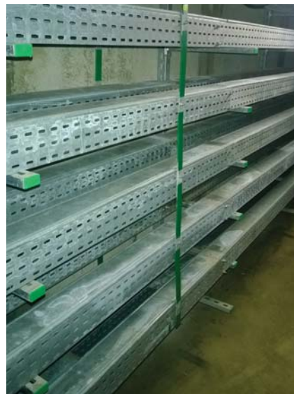
Kabelový kanál po rekonstrukci
