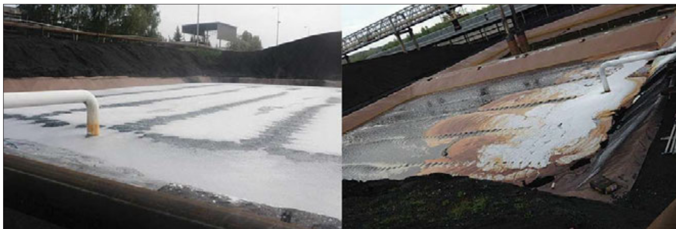
Neutralizace odpadů po chemickém čištění
