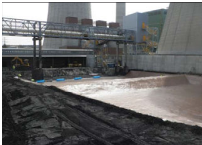
Výstavba neutralizačních bazénů
