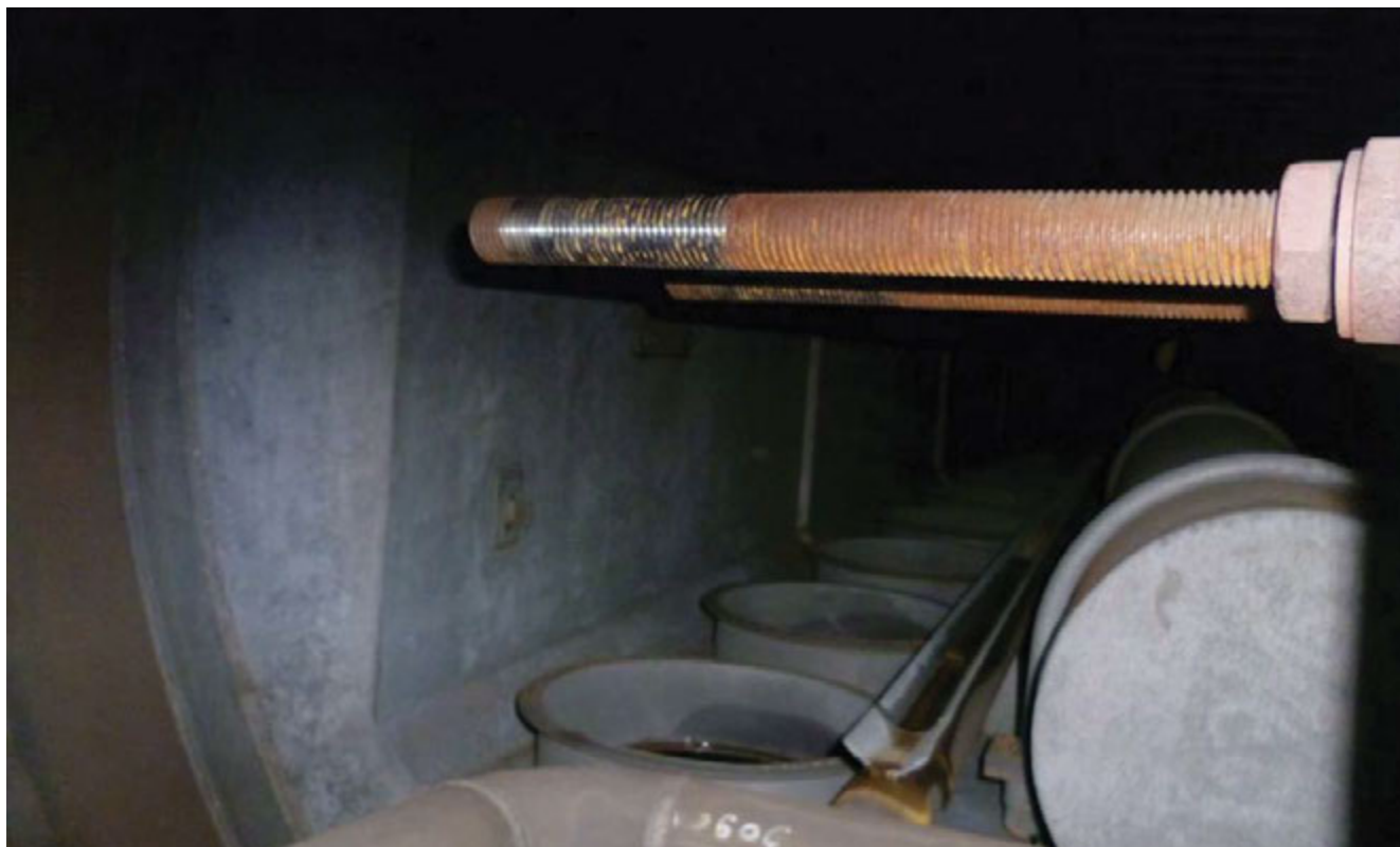
Vnitřní povrch bubnu po chemickém čištění
