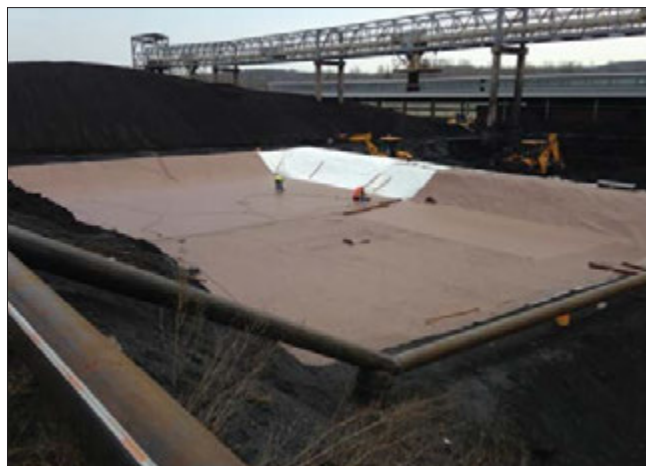
Výstavba neutralizačních bazénů
