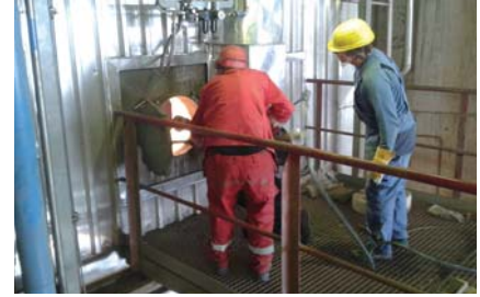
Obr. 11 – Čištění dodatkových ploch za provozu
