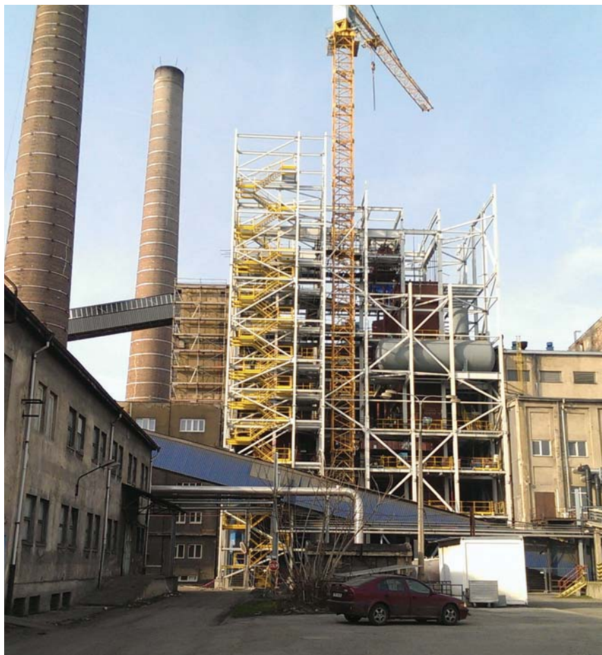
Montáž ocelové konstrukce
