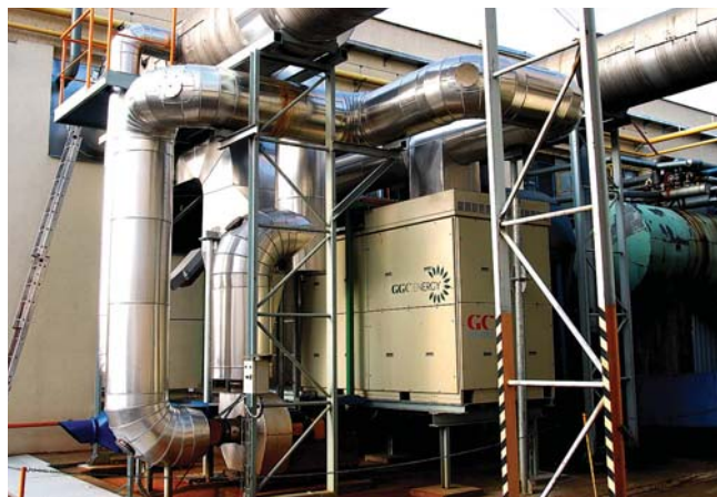
Obr. 3 – Spalovací turbína u kotelny
