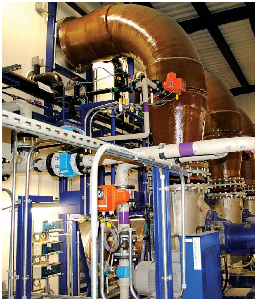
Technologie odsíření spalín
