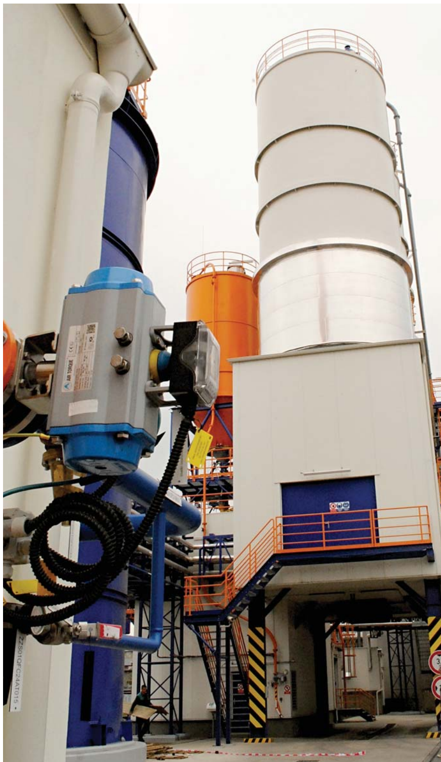
Pohled na pomocné provozy odsíření
