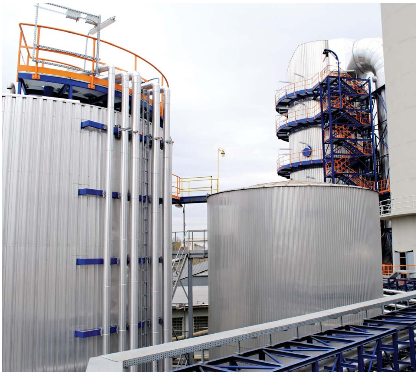
Pohled na objekty odsíření spalin (absorbér vpravo)
