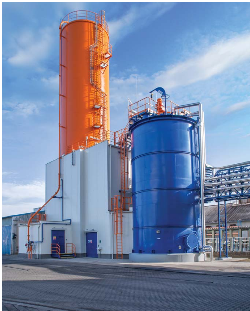
Budova vápencového hospodářství a nádrž zahuštěné sádrovcové suspenze
