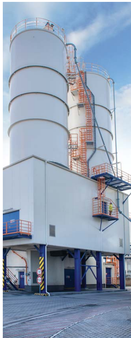
Sila popílku a budova míchání granulátu
