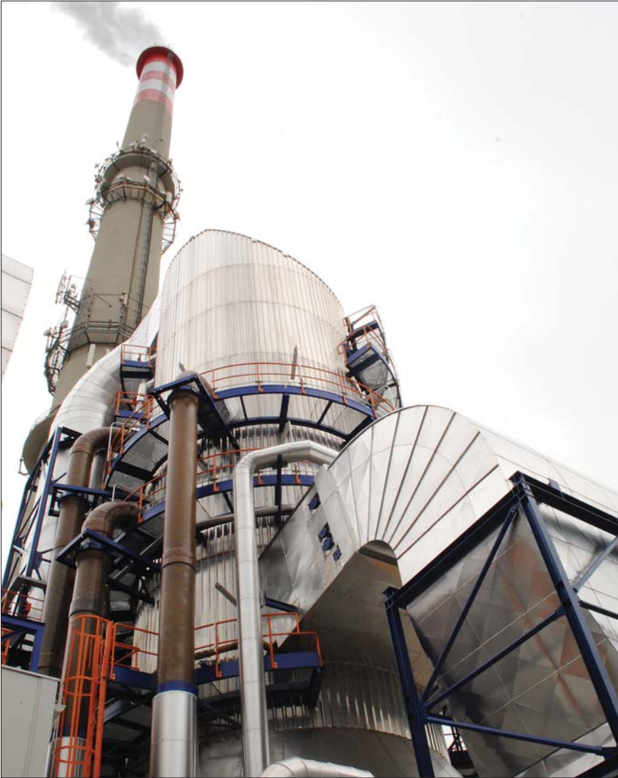
Pohled na objekt odsíření teplárny
