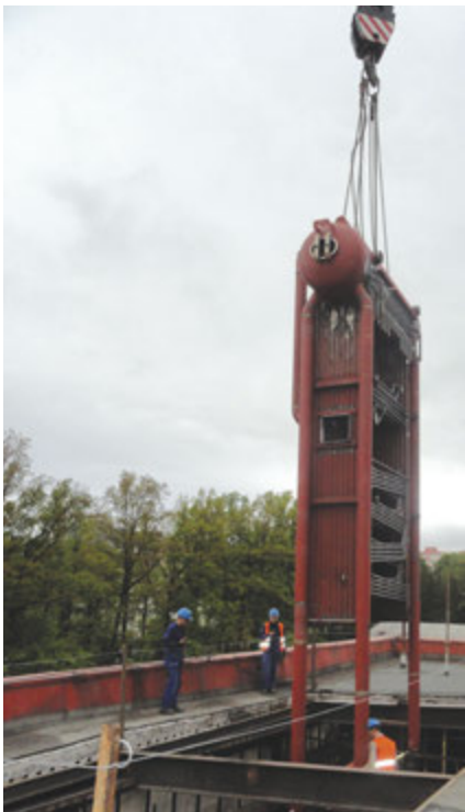
Montáž druhého tahu kotle K 3.1
