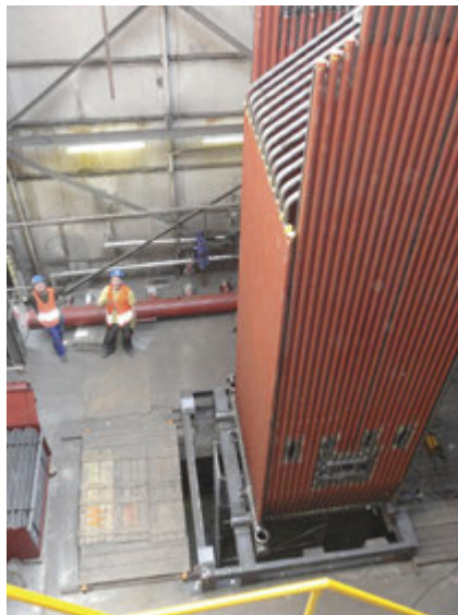
Pohled na spalovací komoru kotle K 4.1
