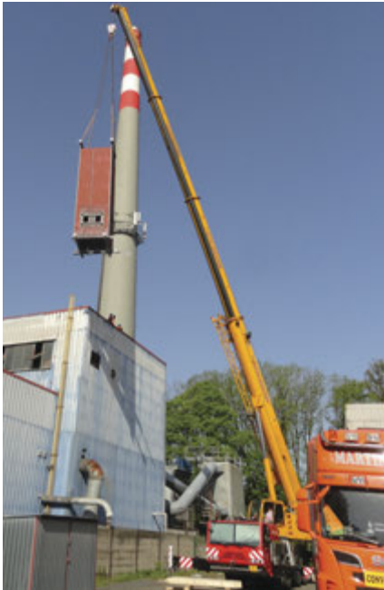
Instalace spalovací komory kotle K 4.1
