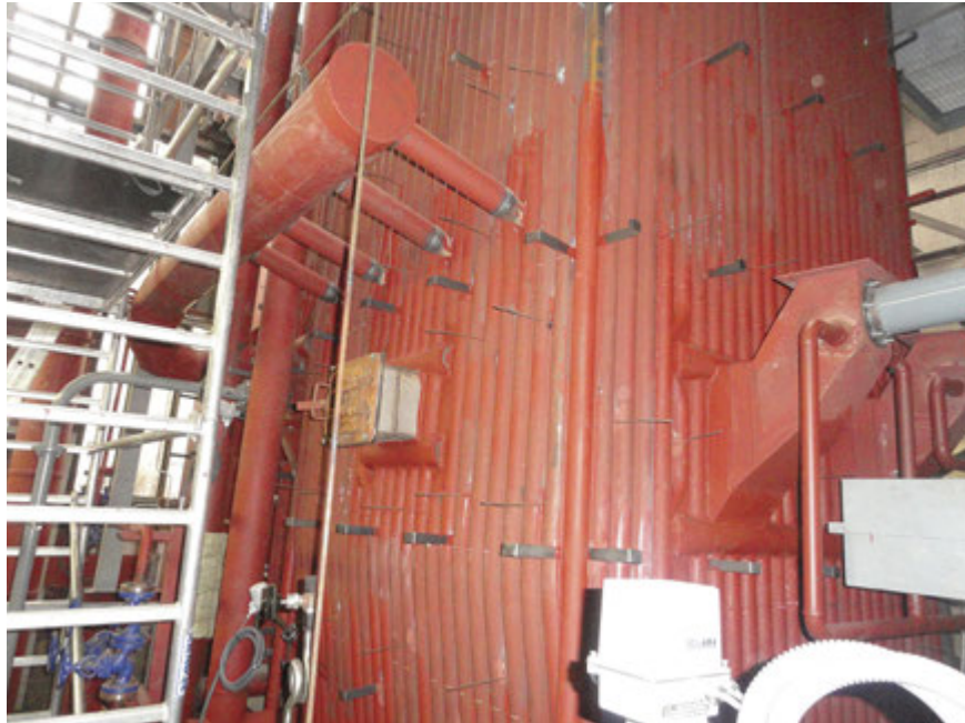
Kompletace kotle K 4.1
