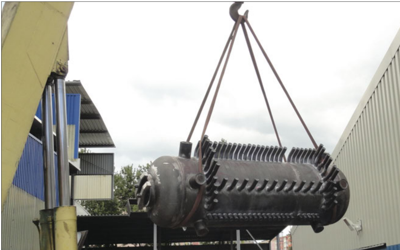
Montáž parního bubnu kotle K 4.1
