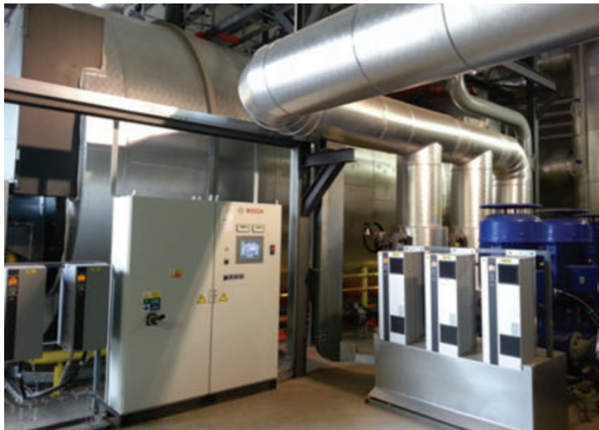
Regulátor kotle a potrubí od kotlů
