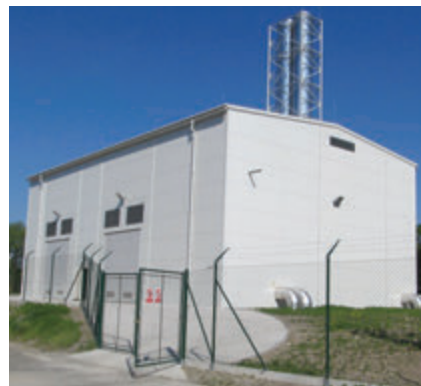
Pohled na objekt kotelny
