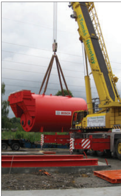
Instalace kotlů Bosch na místo v budoucí kotelně
