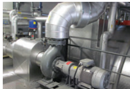
Cirkulační čerpadlo pro jistění teploty vstupní vody
